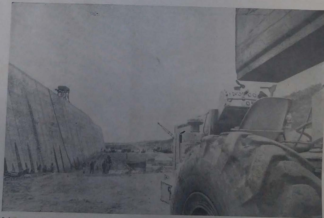
Acham-se prestes a ser concluídas as obras do canal de adução, cuja função será conduzir as águas à casa de máquinas, onde movimentarão as turbinas
