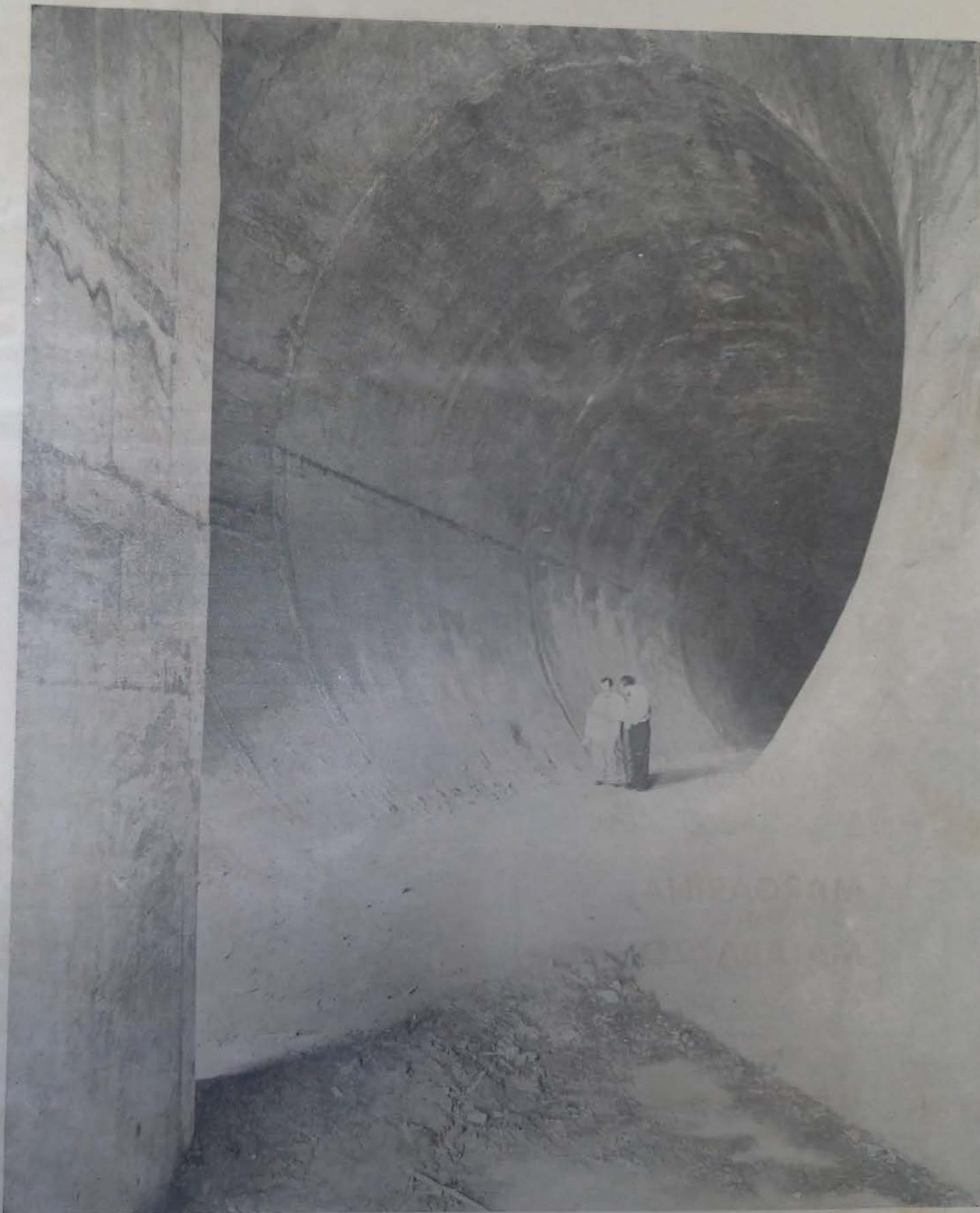
Este é um dos túneis que, primeiramente, servirão para desviar as águas do rio, permitindo a construção da barragem, funcionando, depois, como componentes do sistema de adução.
