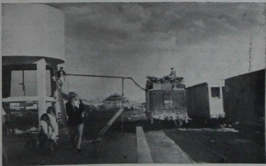
Outro problema da Rede é o abastecimento de água. Obrigados a constantes paradas ao longo da linha, para abastecimento das locomotivas, os trens perdem com isso um tempo enorme.
