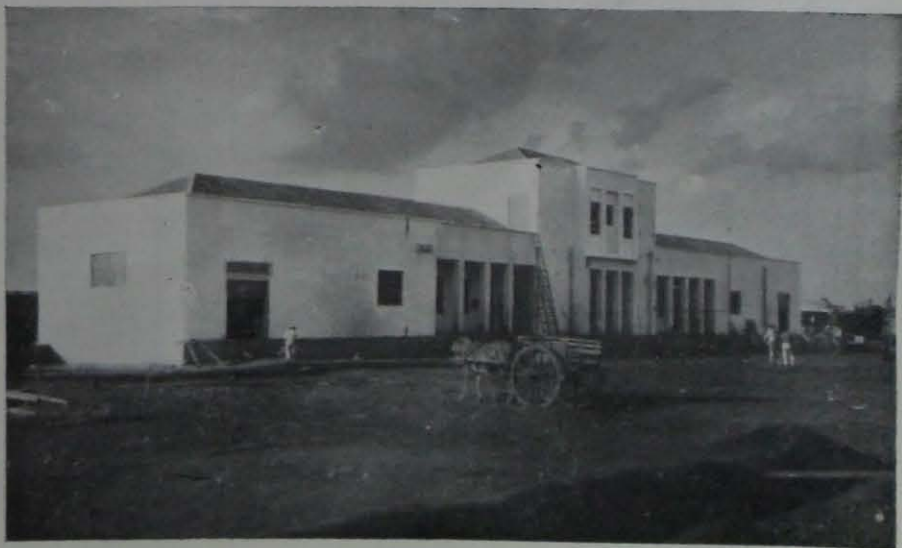
A estação de Maringá fotografada na fase final de sua construção. Desde janeiro de 1954, há um ano, portanto, ela está recebendo regularmente os trens da R.V.P.S.C.
