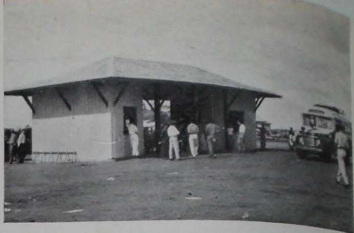
A ESTAÇÃO RODOVIÁRIA
