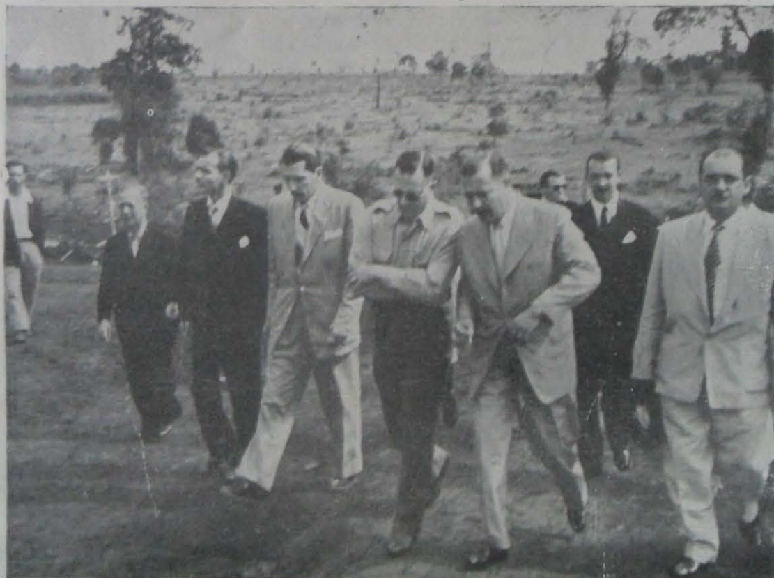
MAIS UM ASPECTO fixado durante a visita às obras da Usina Diesel Elétrica de Maringá
