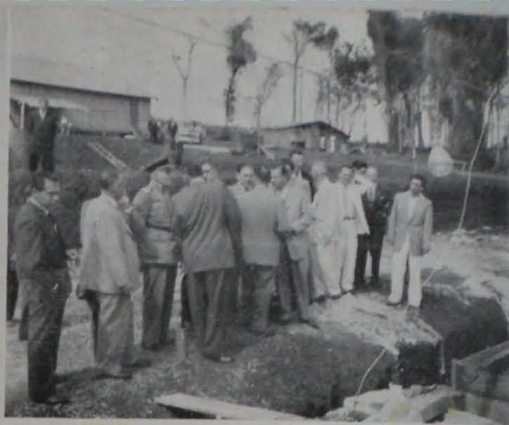
NO LOCAL onde está sendo construída a Usina Diesel Elétrica para a produção de força e luz para a cidade, o Governador Munhoz da Rocha Neto e sua comitiva examinam as obras.
