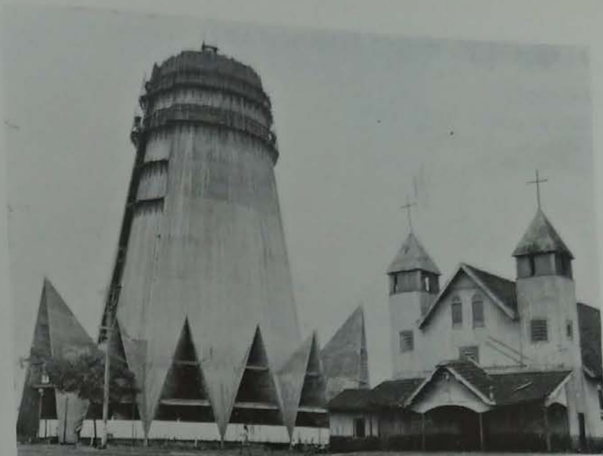
Antiga Catedral de Maringá e a nova em construção
