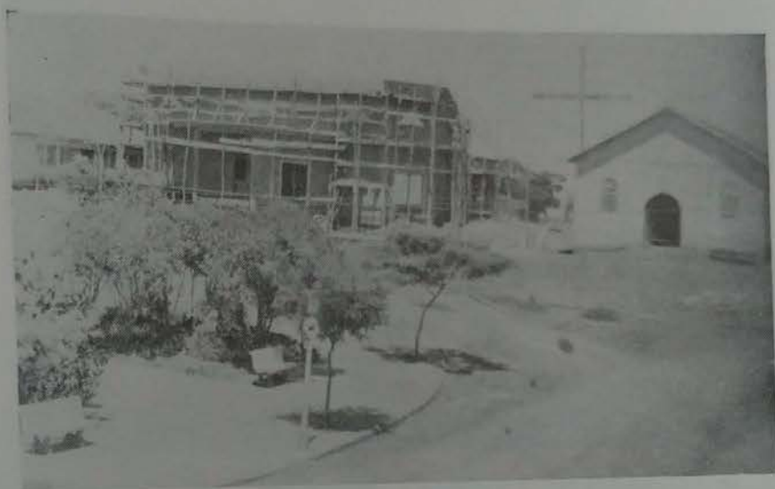
Nova Matriz em construção e 1. a Capela.
