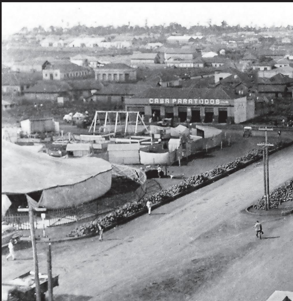
Em 1952, a avenida Brasil contava com o seu traçado e seus canteiros centrais, além de suas guias, executados pela Companhia Melhoramentos Norte do Paraná. Restava a instalação dos paralelepípedos que amenizariam o impacto provocado pela lama e pela poeira.
