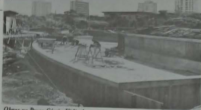
Obras na Praça Cássio Vidigal.
