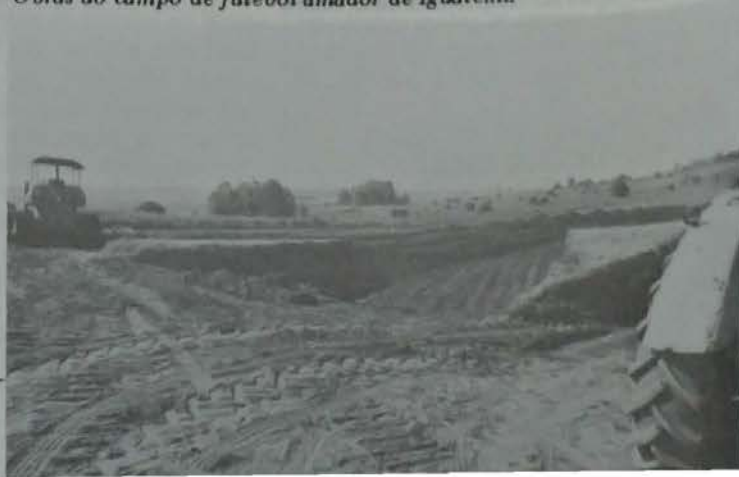
Obras do campo de futebol amador de Iguatemi.
