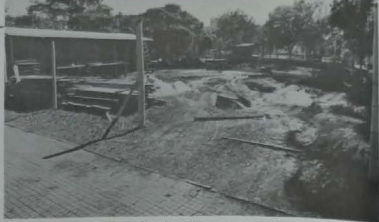
Obras do coreto na Praça Emiliano Perneta.
