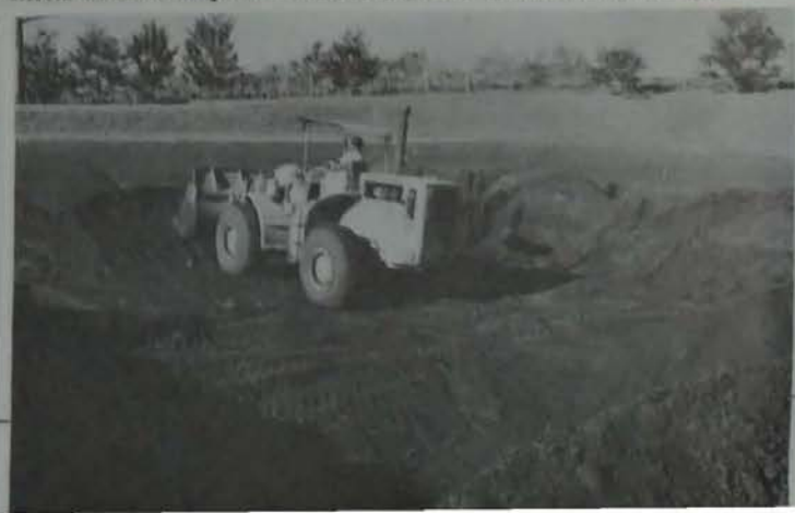
Início de obras da piscina da Associação de Funcionários Municipais.
