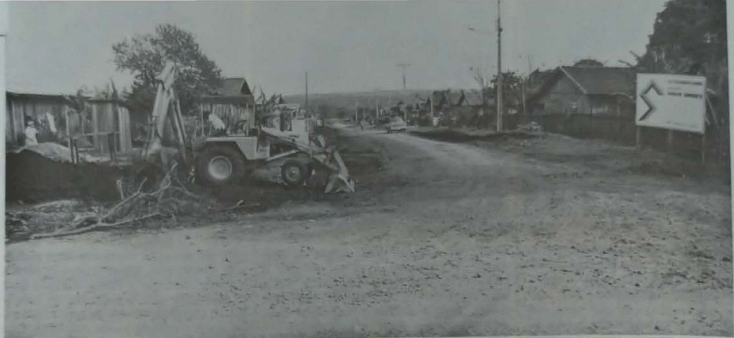
Obras na Vila Vardelina.
