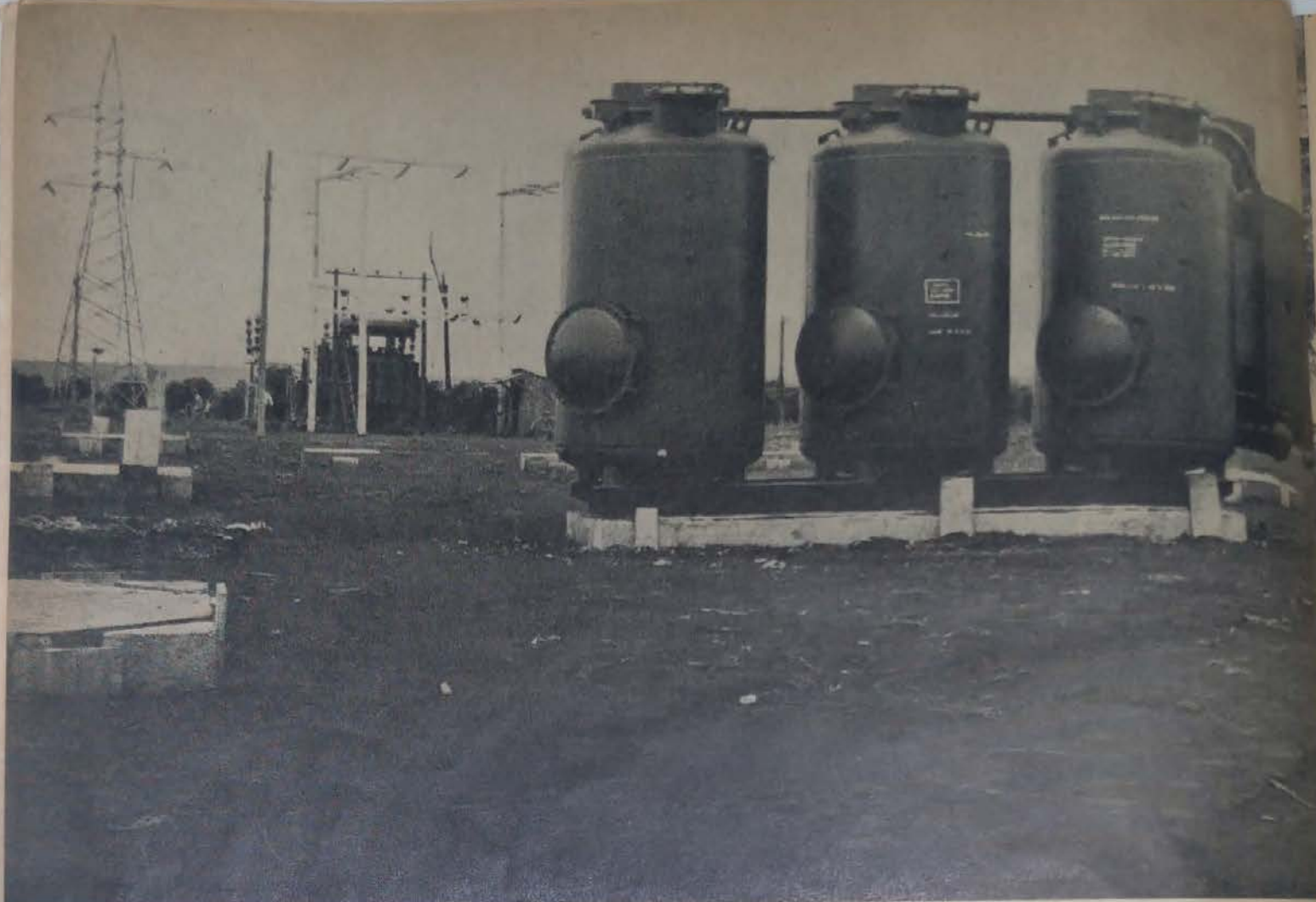
Montagem dos equipamentos da nova subestação transformadora em construção em Maringá.
