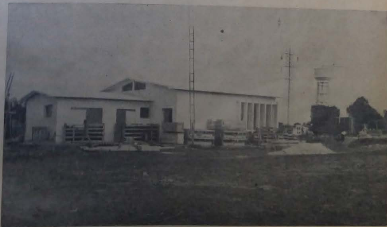
Subestação transformadora de Londrina (20.000kVA), em construção, vendo-se em primeiro plano a casa de comando e controle.
