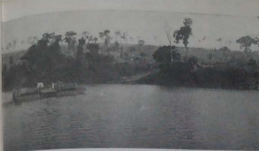
A construção da ponte sobre o Piquiri no Porto IV é uma reivindicação de vários municípios. O proprietário da balsa é fazendeiro na região e se inclui entre os que pedem urgência para a ponte.
