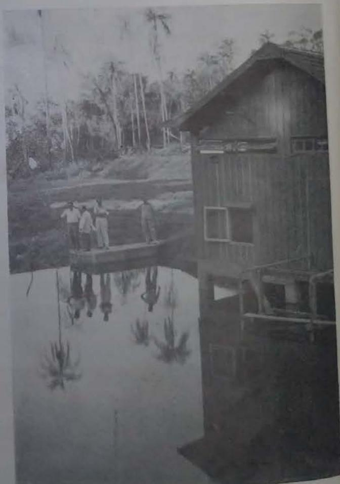
Casa das máquinas, no ribeirão São Tomé, onde está instalado o serviço de recalque da rede de água de Cianorte. Veja-se a cristalinidade da água, no admirável reflexo, principalmente, da casa aludida.
