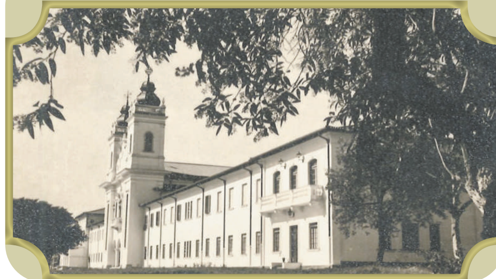
Foto 44 - Parcial da fachada de frente, contendo a entrada da capela.
