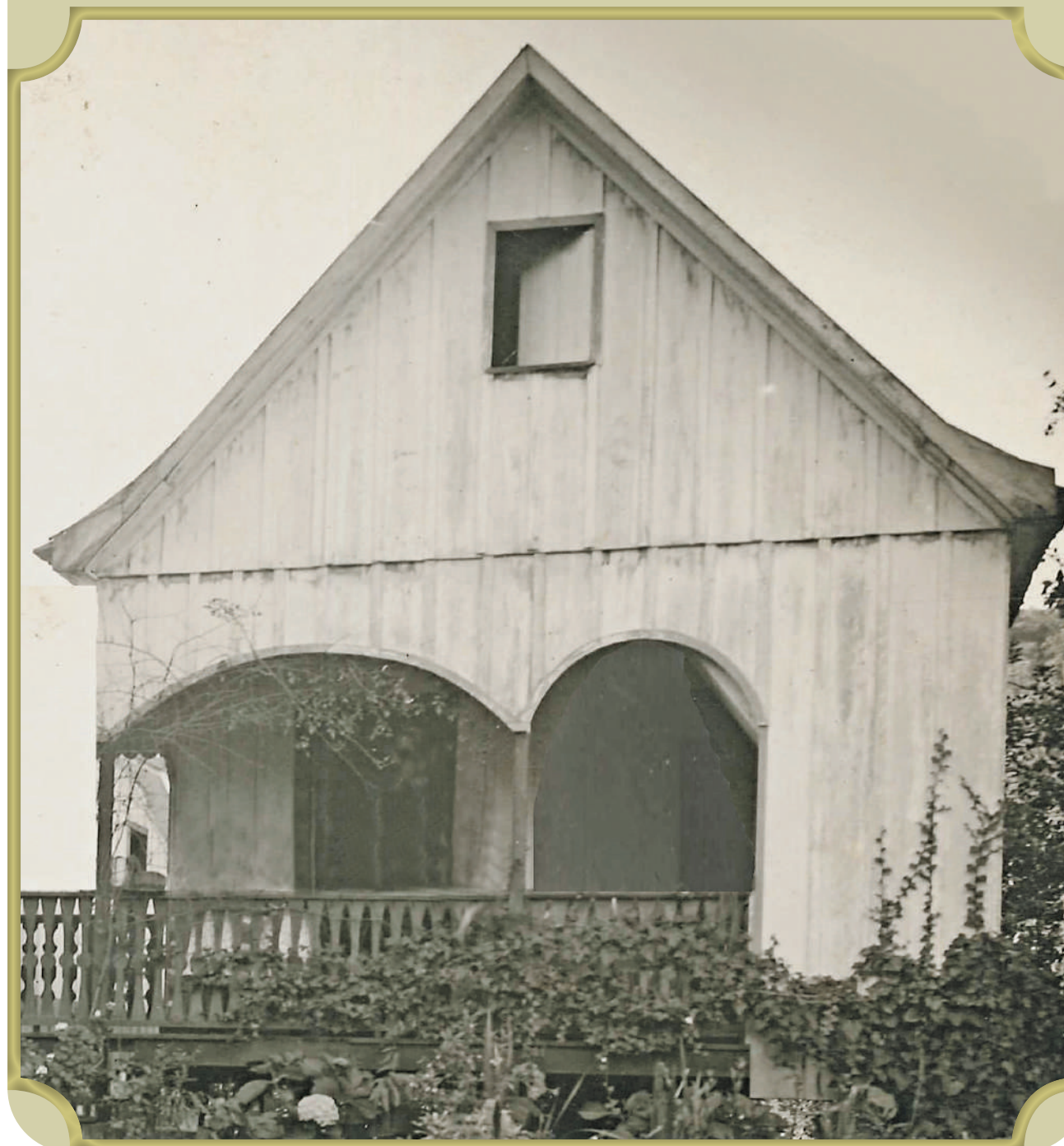
Foto 19 - Casa (6mx8m) construída em 1937 por Paulino em Barra do Estreito/Bom Retiro (SC), hoje Luzerna (SC). Casa típica de moradias germânicas com cumeeira alta, para otimizar a utilização do sótão.
