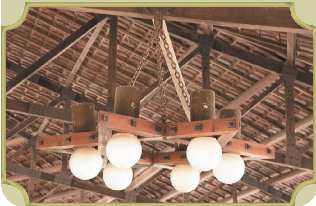
Foto 150 - Uma das cinco luminárias.
