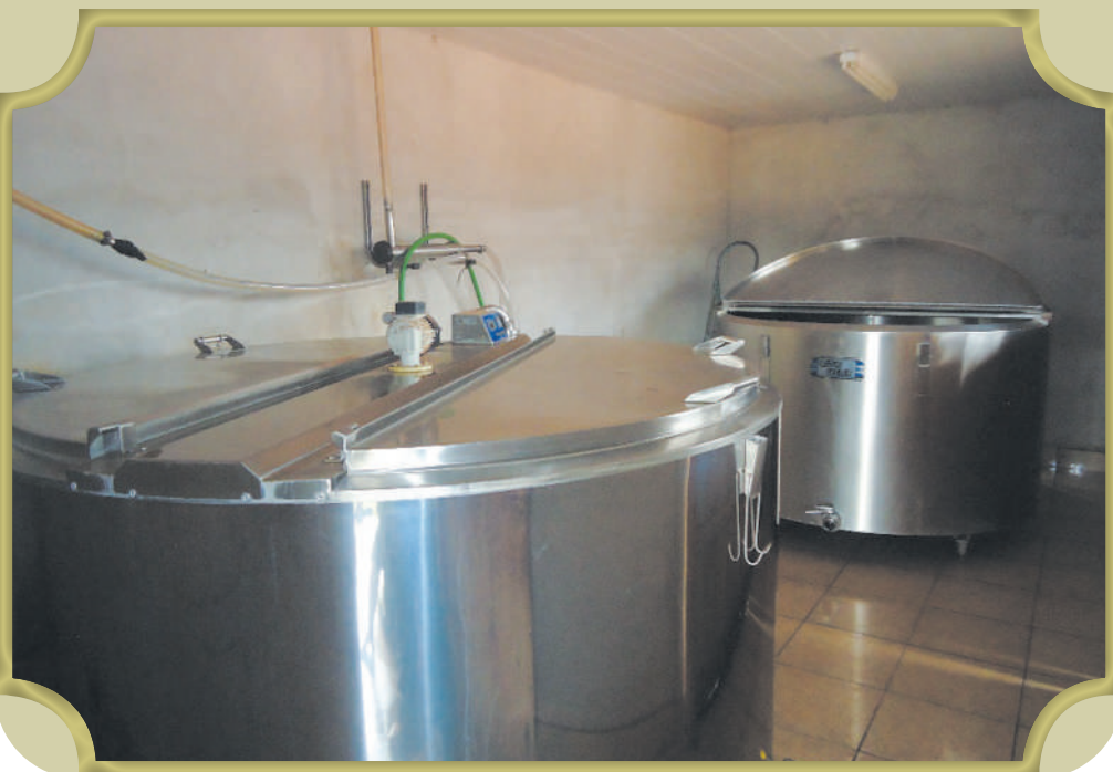
Foto 200 - Sala de resfriadores (capacidade 4.000 litros).
