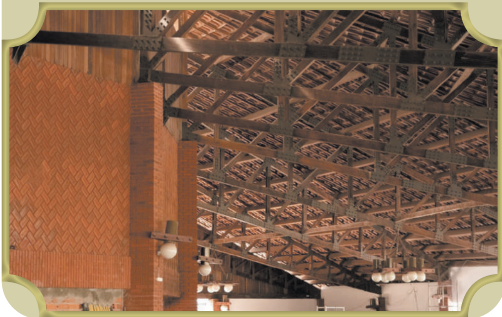
Foto 149 - Onze tesouras com 16 m de comprimento cada, em peroba aparelhada, sustentam o encaibramento e enripamento da cobertura em telhas cerâmicas.
