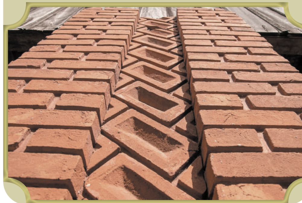
Foto 147 - Detalhe do acabamento em tijolos à vista batidos na areia.
